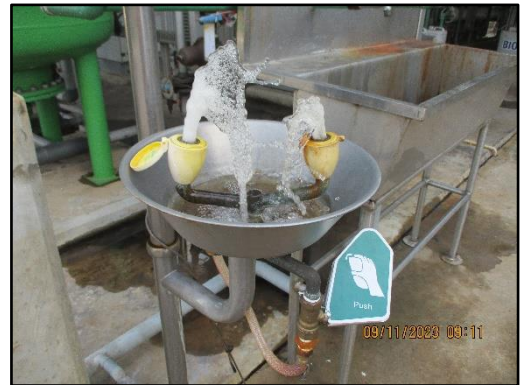
ภาพที่ 2.41 อ่างล้างตา และฝักบัวฉุกเฉิน
