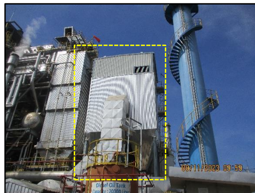
ภาพที่ 2.2 ระบบดักฝุ่นแบบถุงกรอง (Bag Filter)
